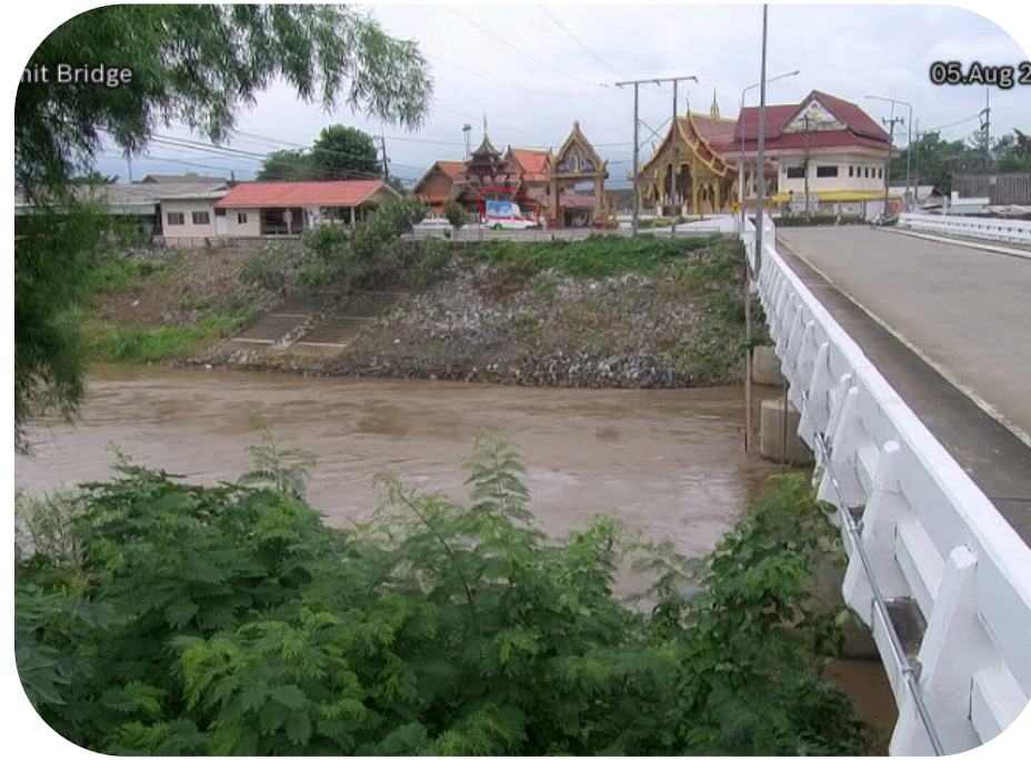
สะพานประชานิยม อ.แม่ริม จ.เชียงใหม่
